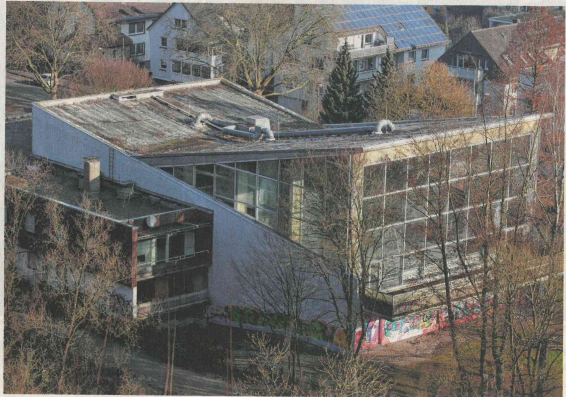
Das alte Hallenbad am Feauxweg weist die klassische Architektur der frühen 60er Jahre auf. Eine privatwirtschaftliche Folgenutzung konnte jedoch nicht gefunden werden - jetzt folgt der Abriss.
