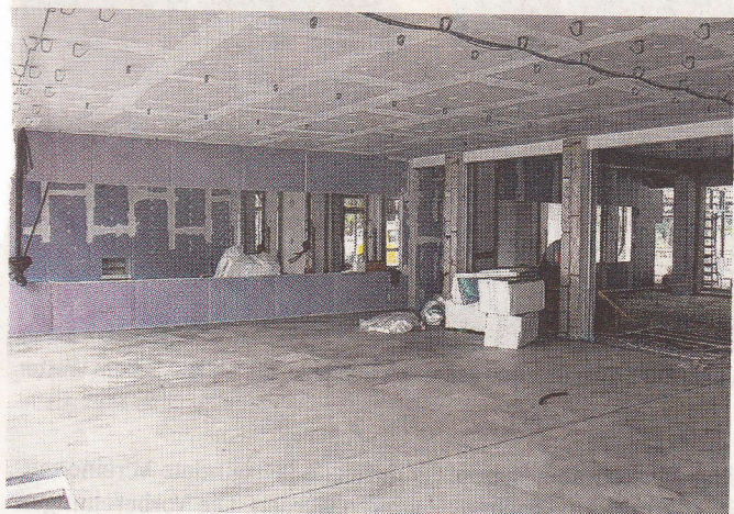
Die Arbeiten an den beiden Sekundarschulstandorten laufen bislang im vorgegebenen Rahmen.
